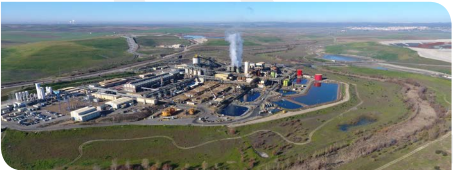
Hydrometallurgical plant, Cobre las Cruces
